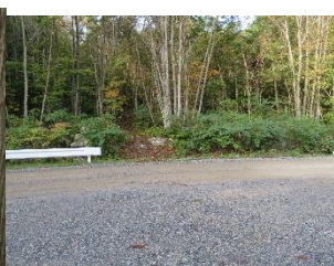
工事中の道路
