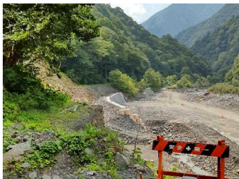
災害復旧工事現場
