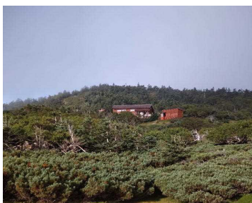
センジヶ原から見る光岳小屋
